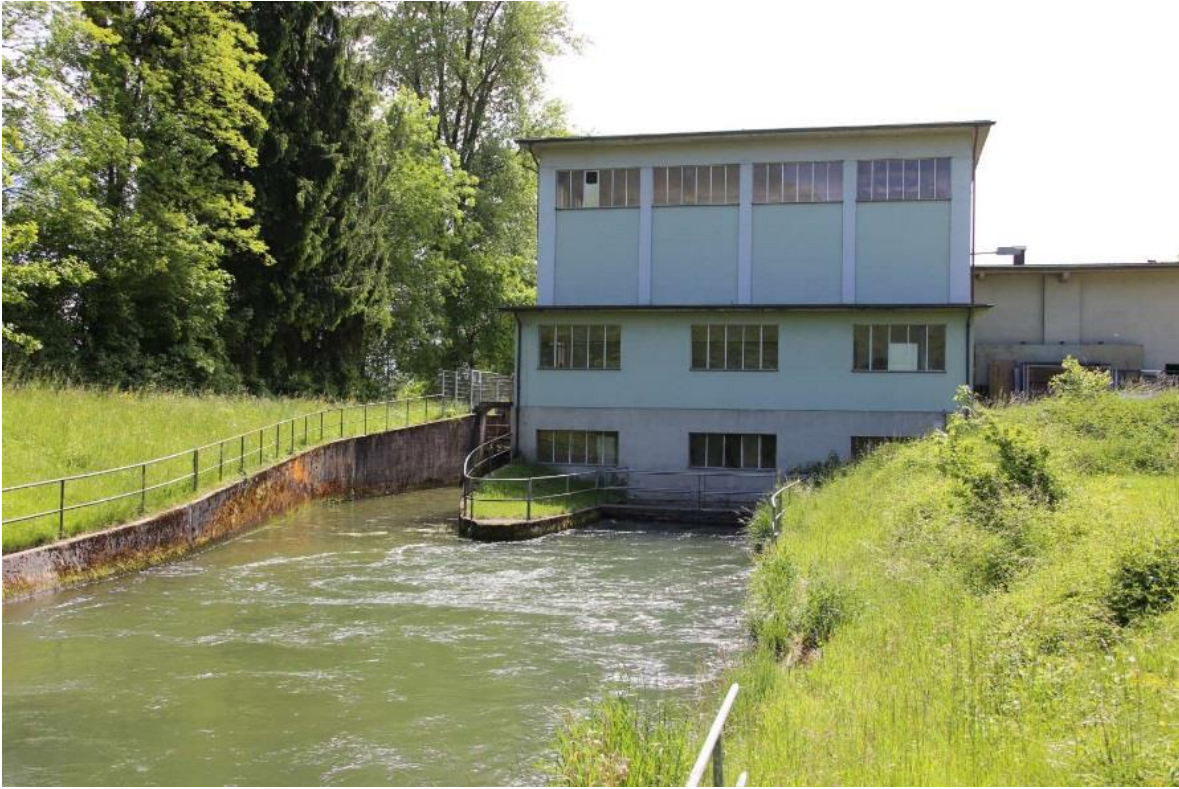
Die neu erworbenen Wasserkraftwerke Moosbrunn in Wiler bei Utzenstorf trugen 2014 zu den guten Stromerträgen bei. Foto: ADEV
